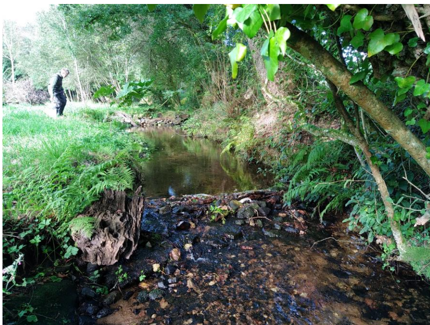
Seuils transversaux dans le lit du cours d'eau_station 29STEI15
